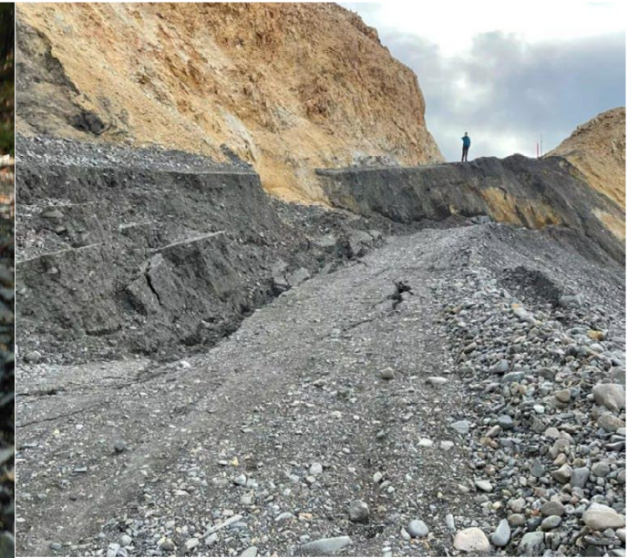
Permafrost thaw+landslides Denali NP
